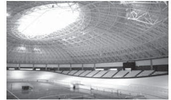
屋内型 250m 板張りトラック
